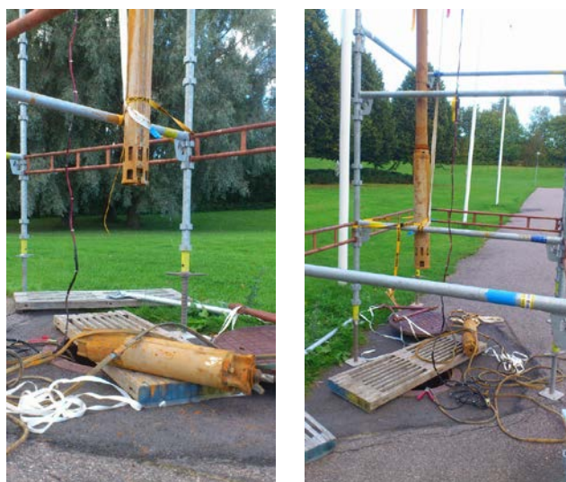
Grundvattenpumpen uppe för reparation
